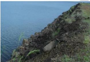
**b) Protección con elementos prefabricados de hormigón**
